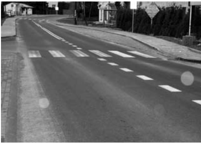
Droga po remoncie
