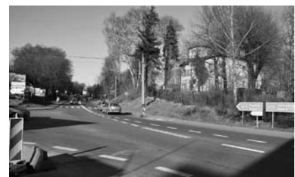
W czasie intensywnych opadów deszczu na skrzyżowaniu tworzyły się zalewiska
