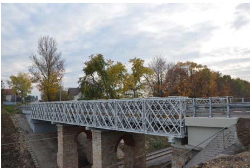
Wyremontowany wiadukt na ulicy Piaskowej w Gorzycach
