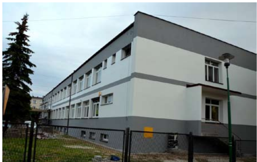
Ośrodek zdrowia w wodzisławskiej dzielnicy Wilchwy po termomodernizacji
