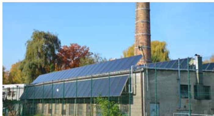
Na kotłowni zainstalowano 100 solarów.
