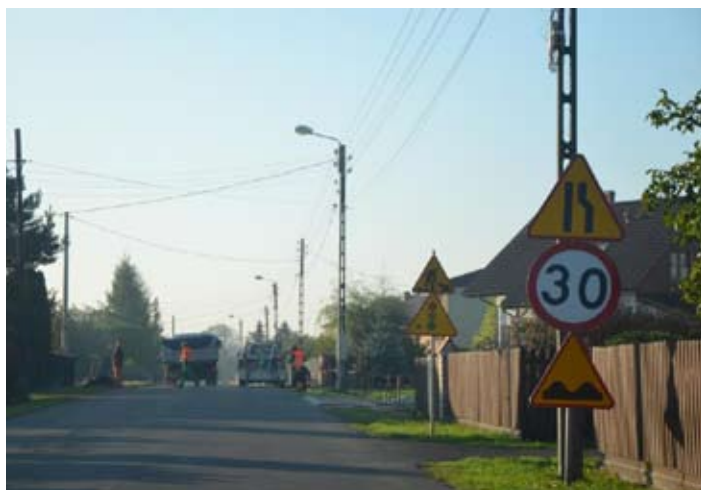
Ulica Skrzyszowska jeszcze podczas remontu.
