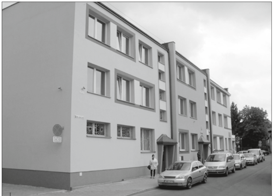
Budynek Powiatowego Urzędu Pracy po termomodernizacji.
