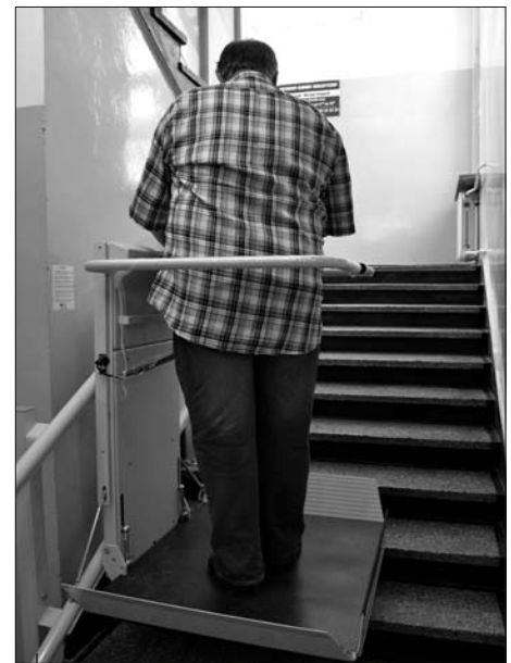
Platforma przyschodowa umożliwi osobom niepełnosprawnym dostać się na wyższą kondygnację budynku.
