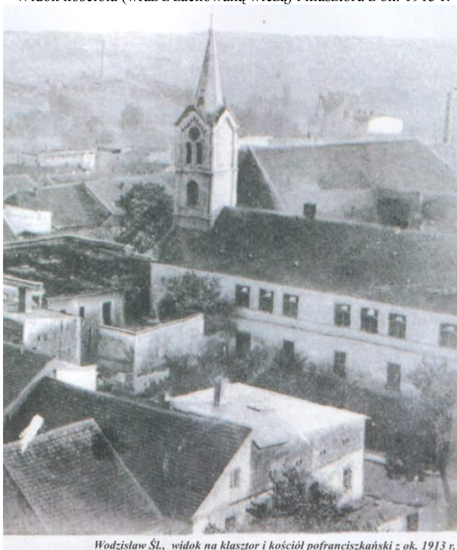
Rys. 2 Zespół pominorycki w Wodzisławiu Śl. Widok kościoła (wraz z zachowaną wieżą) i klasztoru z ok. 1913 r.
