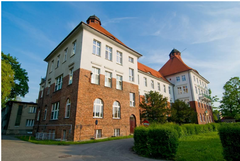
Rys. 36 Budynek szpitala w Rydułtowach (pocz. XX w.)
