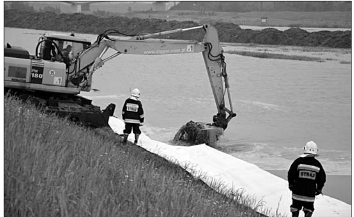
Strażacy podczas zabezpieczenia wału w Bukowie.
