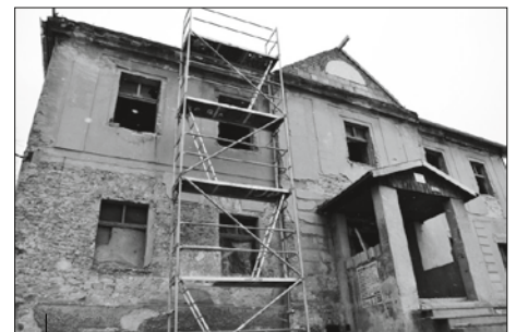
Budynek przed remontem.
