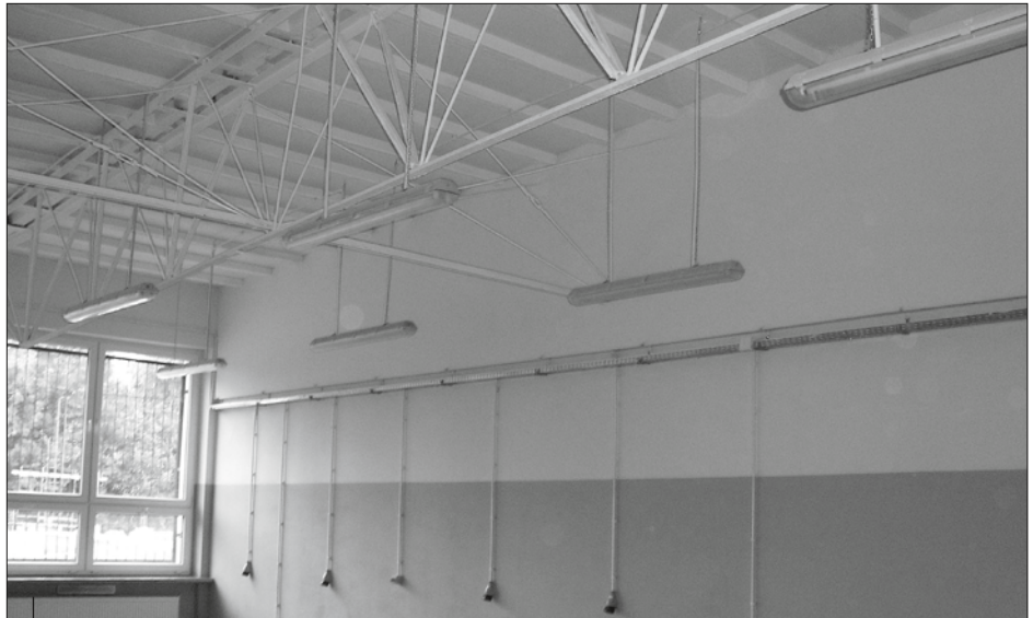
W pierwszym etapie robót powstał m.in warsztat obróbki ręcznej.
