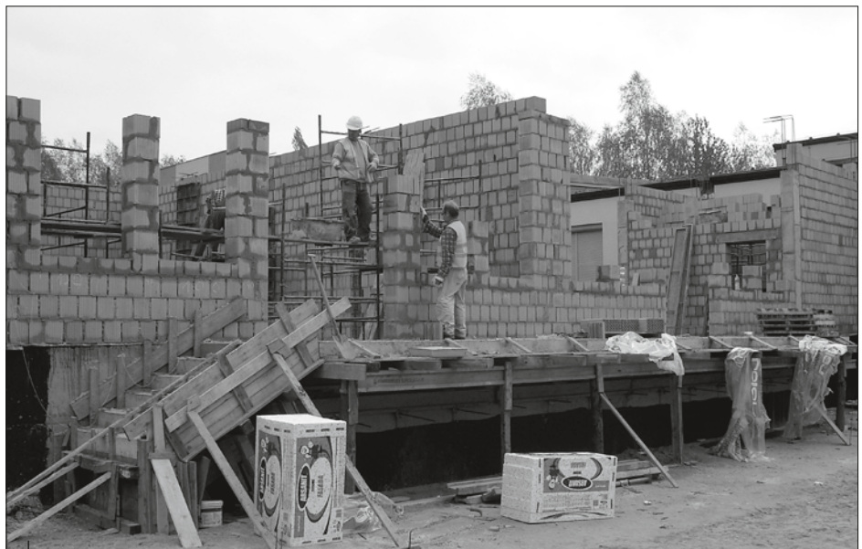
Obecnie trwa rozbudowa PCKU o nowe pracownie i warsztaty szkolne.
