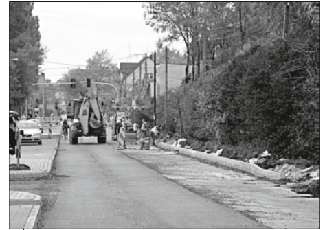
Przebudowa ul. Traugutta w Pszowie ma zostać ukończona 22 listopada.
