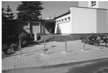
Wyremontowane wejście główne do budynku PCKU.
