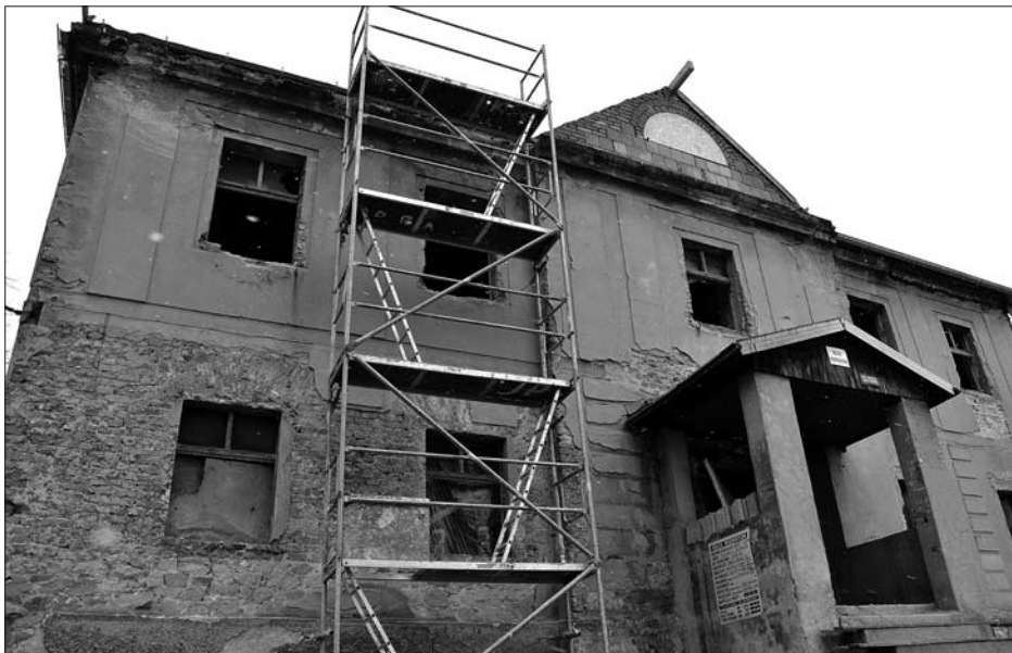
Obecnie trwa remont budynku byłego probostwa w Połomi.
