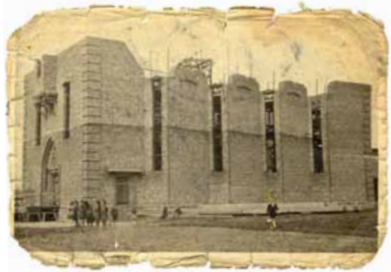
Budowa kościoła w Turzy Śl.
