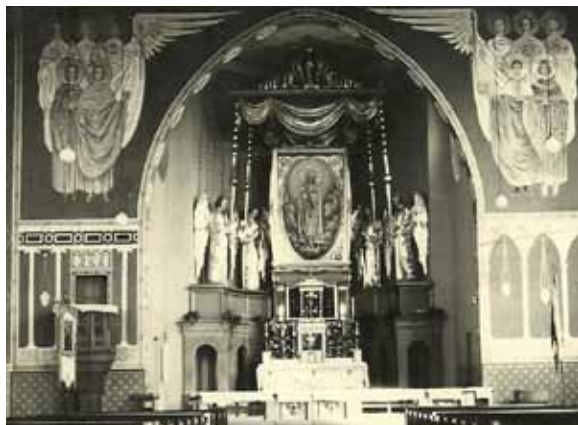
Widok ściany tęczowej z pierwotną polichromią i prezbiterium po zmianie ołtarza
