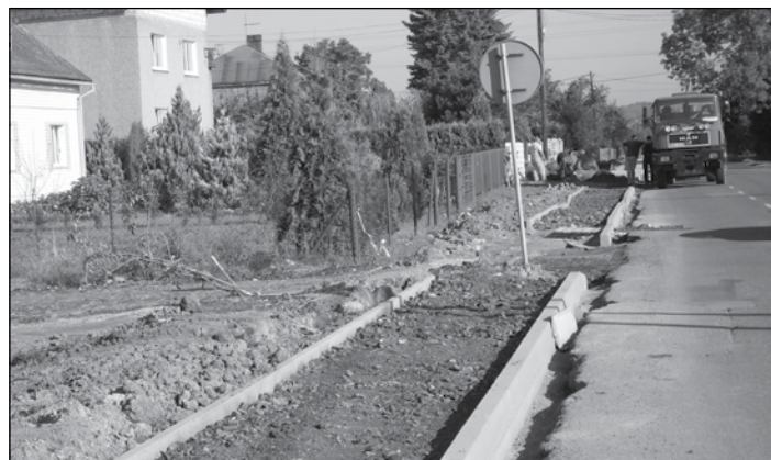
Gołkowiec-ul. 1 Maja ( w trakcie realizacji)
